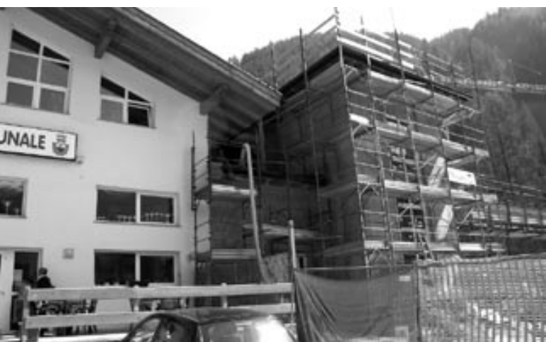
Gli ultimi lavori di ampliamento dell'impianto
