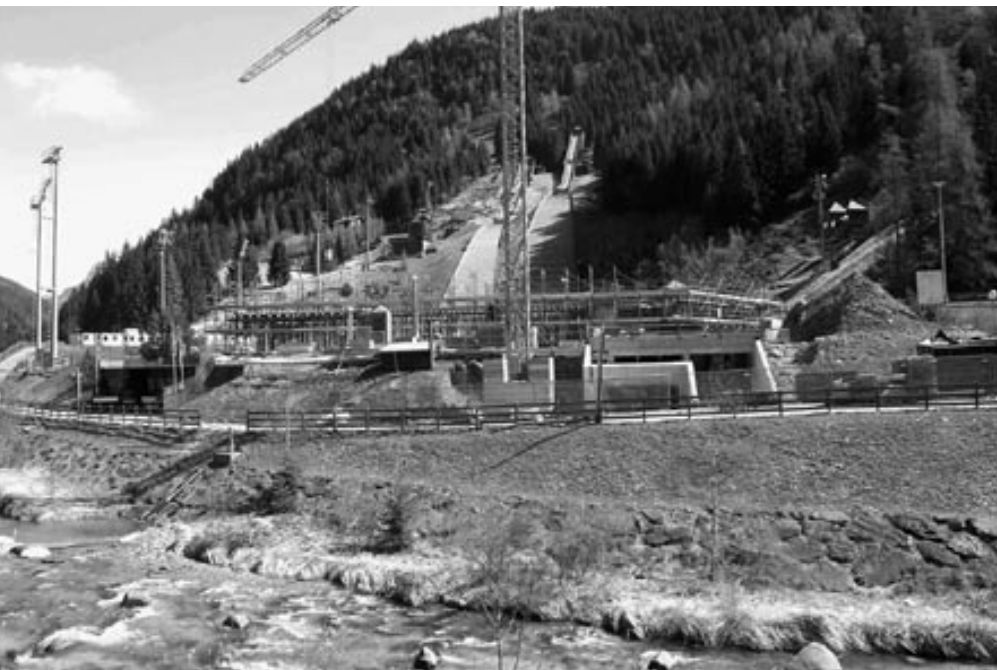
Nella foto a fianco: i lavori in corso presso il Centro del Salto
