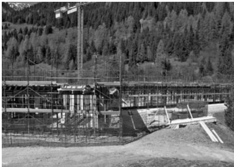
I lavori in corso presso il Centro del Salto
