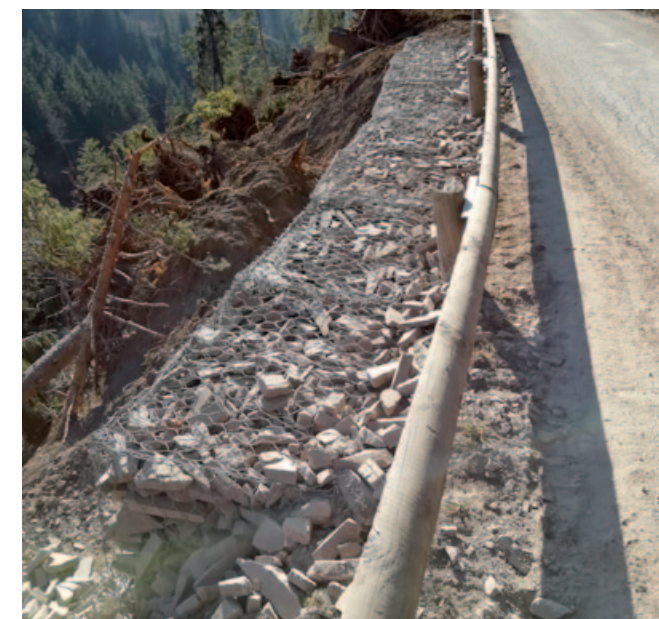
Gabbionate ancorate per il consolidamento della scarpata a valle della strada di Valmaggior
