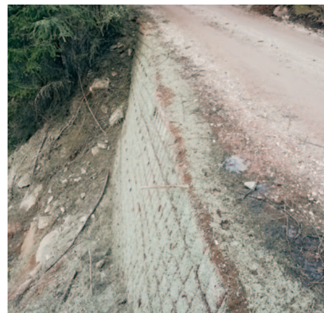
Consolidamento scarpata con terra armata a valle della strada della Bedovina
