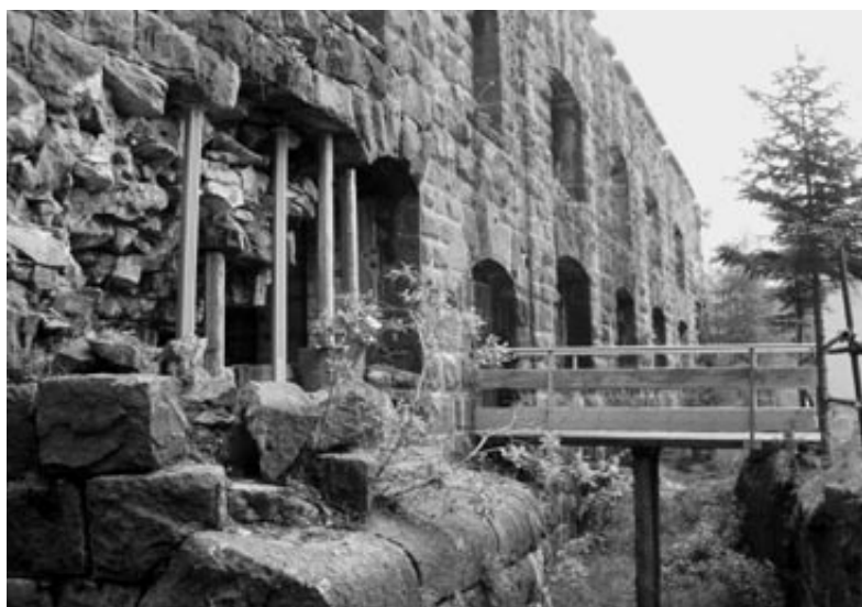
I lavori in corso
