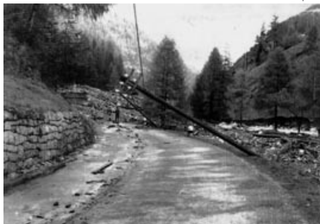
Al Fol: frana sulla statale 48
